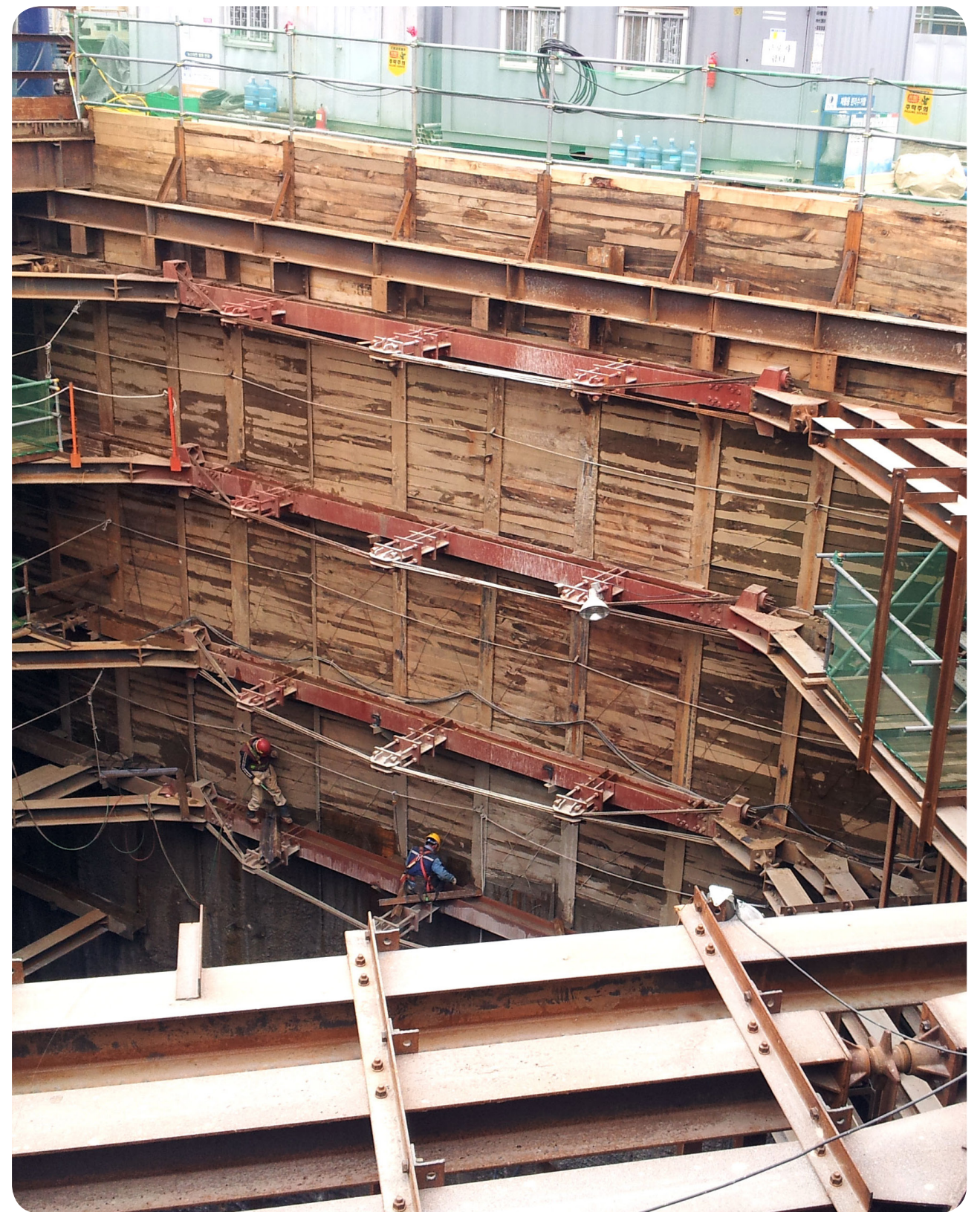
• 수도권 고속철도 제 1-2공구 노반신설 기타공사 / 44.7m*16.5m*22.866m, 토압=130kN/m 9.6m ROSE 띠장 8EA 적용
