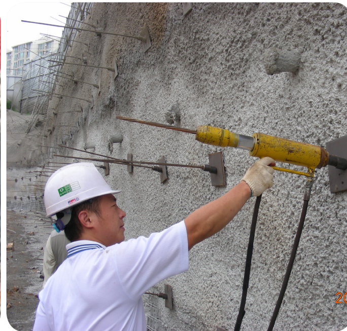
6. 슛크리트 타설 및 지압판 설치
