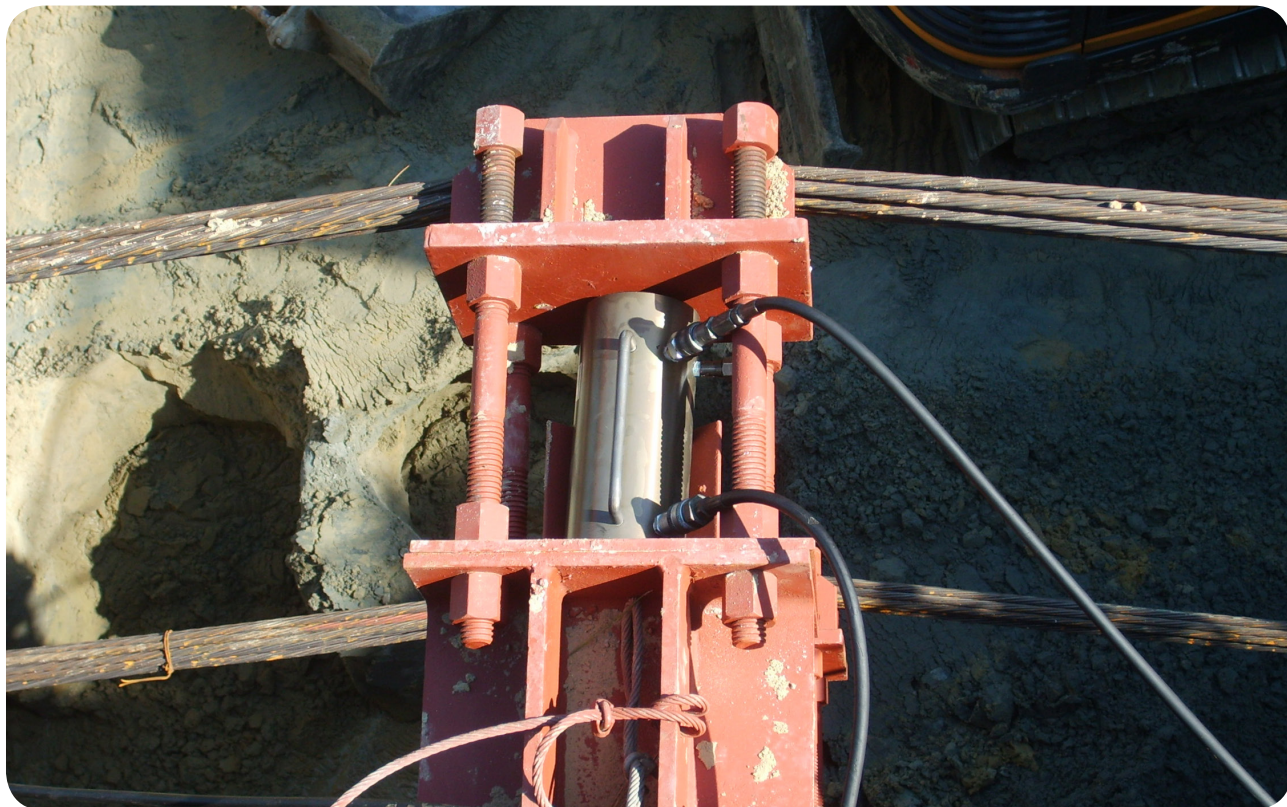
● 구시포 하수처리장 증설공사 가시설 / 25.0m*12.0m*10.0m, 토압=160.0kN/m 9.6m, 7.6m ROSE 띠장 적용
