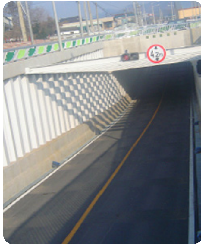
• 함창 과선교 지하 입체화 공사 / 총연장 200m BOX-Type 33m U-Type 167m
