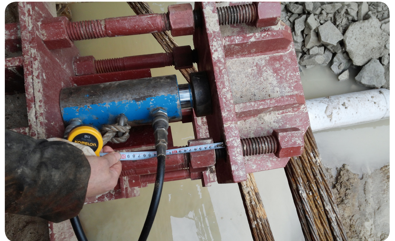
● 김제시저류조 설치사업 가시설 / 118.0m*27.0m*14.0m, 토압=201.0kN/m 9.6m ROSE 띠장 적용
