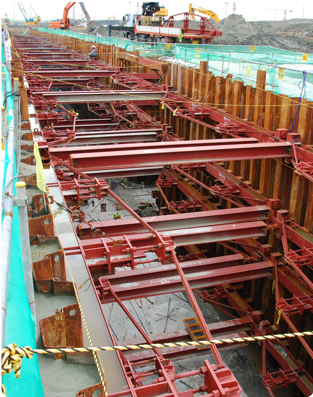
• 송도국제업무시설 NSC공동구 가시설 / 750m*15m*15m, 토압=135kN/m 9.6m ROSE 띠장 적용
