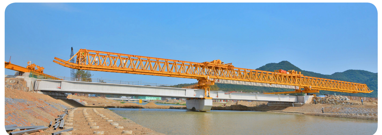
• 지사2교 / L=2@41m , B=21.9m , H=2.1m , Beam Weight=154ton
