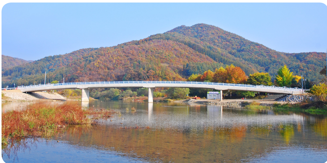
• 선바위교 / L=4 \times 27.5=110m , B=6m , H=0.9m , Skew=90^\circ
