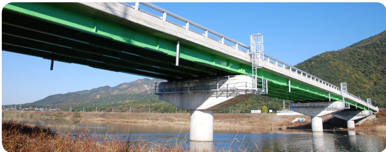
• 인천교 / L=31\text{m}+2@35\text{m}+31\text{m}=132\text{m} , B=9.5\text{m} , H=0.8\text{m}
