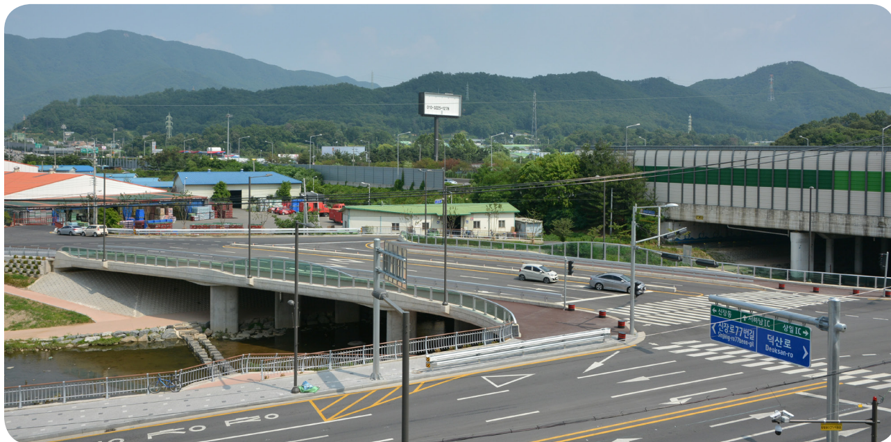
• 덕산교 / L=18m+20m+22m=60m , B=28m , H=0.7m , Skew=60^\circ
