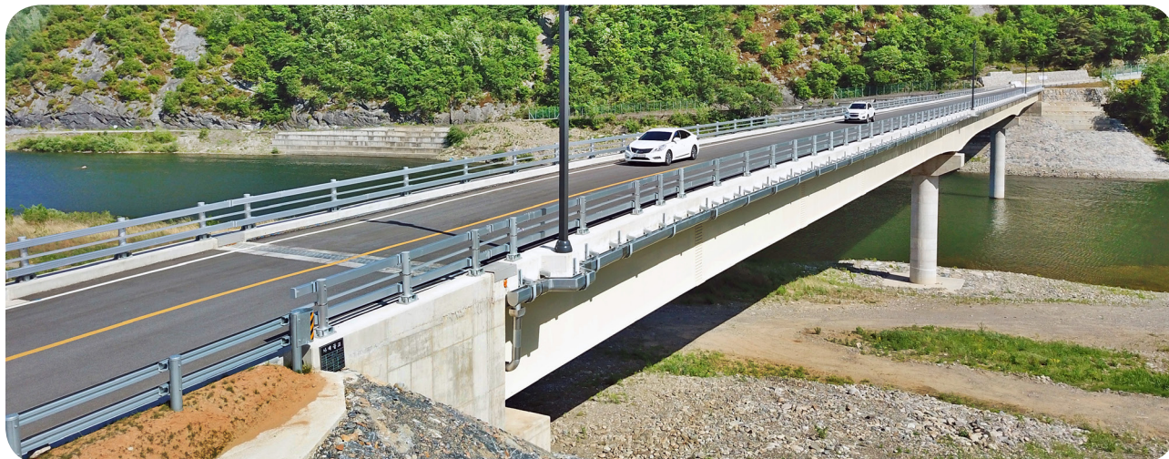
• 가재골교 / L=83.6m+90m+83.6m=257m , B=8.5m , H=2.4\sim2.8m
