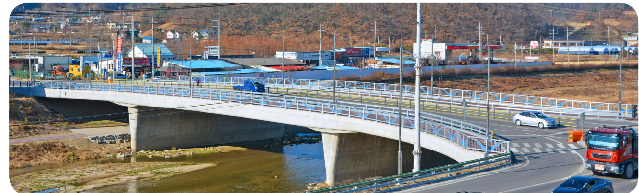
• 아트교 / L=29m+39m+29m=97m , B=30m , H=0.8m
