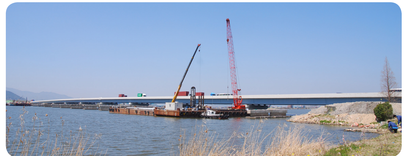
• 서낙동강교 / L=45.28m+45m+3@60m+60.28m+5@60m=630m , B=24.3m , H=2.4m
