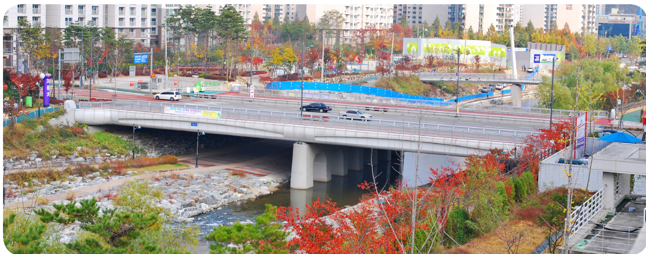
• 구숫내교 / L=2@32\text{m}=64\text{m} , B=37\text{m} , H=0.991\text{m} (화장판 마감)
