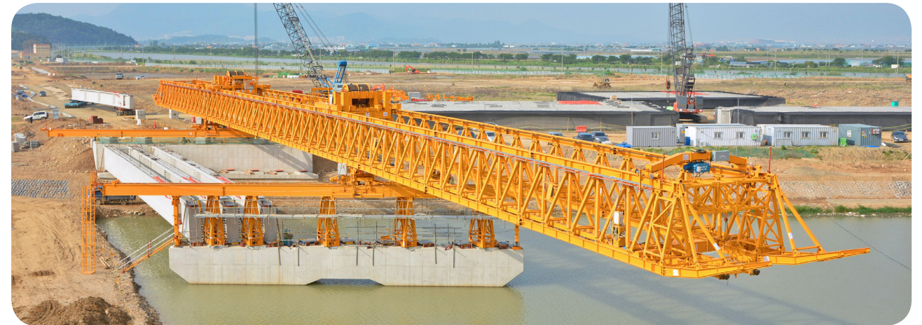
• 지사1교 / L=2@49m , B=27.9m , H=2.7m , Beam Weight=157ton
