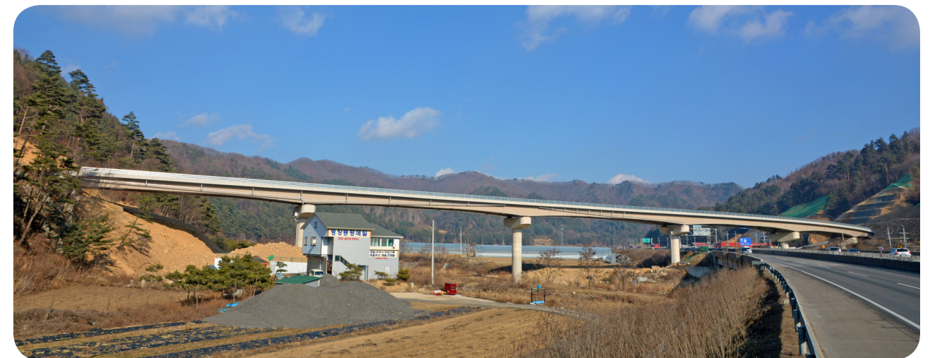
• 장평3교 / L=45m+4@55m+45m=310m , B=12.4m , H=1.6\sim2.6m , R=300
