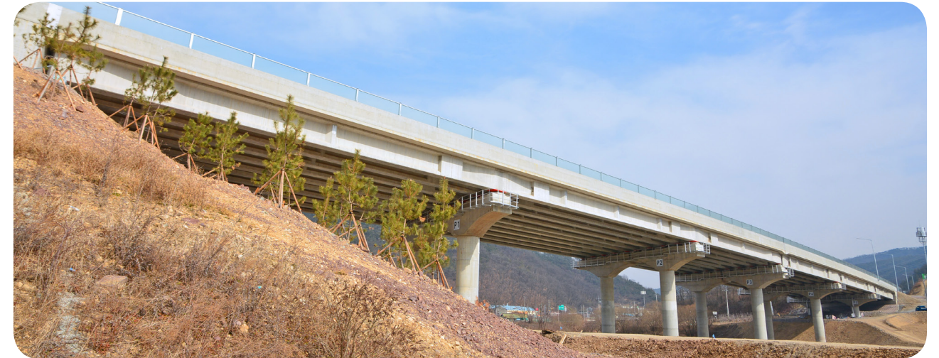
• 미천교 / L=35m+40m+35m+40m+45m+40m=235m , B=24.7m , H=1.9m
