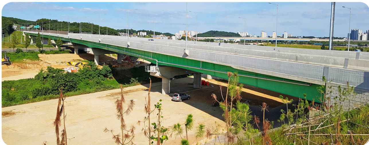
• 천천교 / L=43m+69m+43m+58m+69m+69m+43m=394m , B=21m , H=2.5m , R=1800
