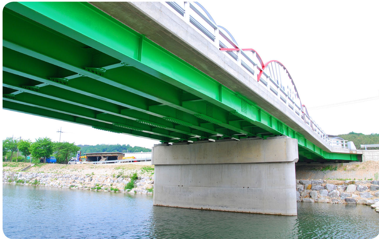
• 석곡교 / L=2@26m=52m , B=11\sim18m , H=0.8m (시,종점부 확폭적용)
