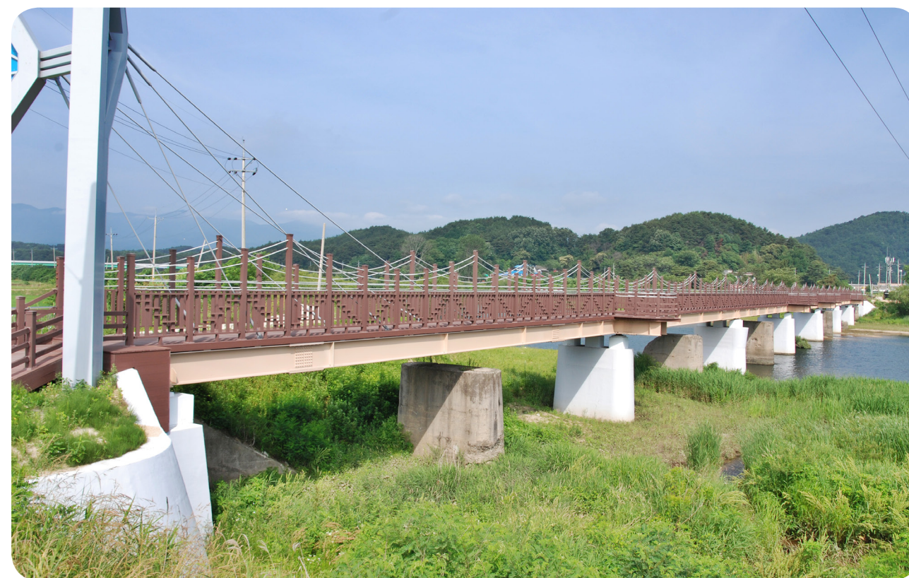
• 북천보도교 / L=200\text{m} , B=3\text{m} , H=0.7\text{m} (기존 철도 교각 활용)
