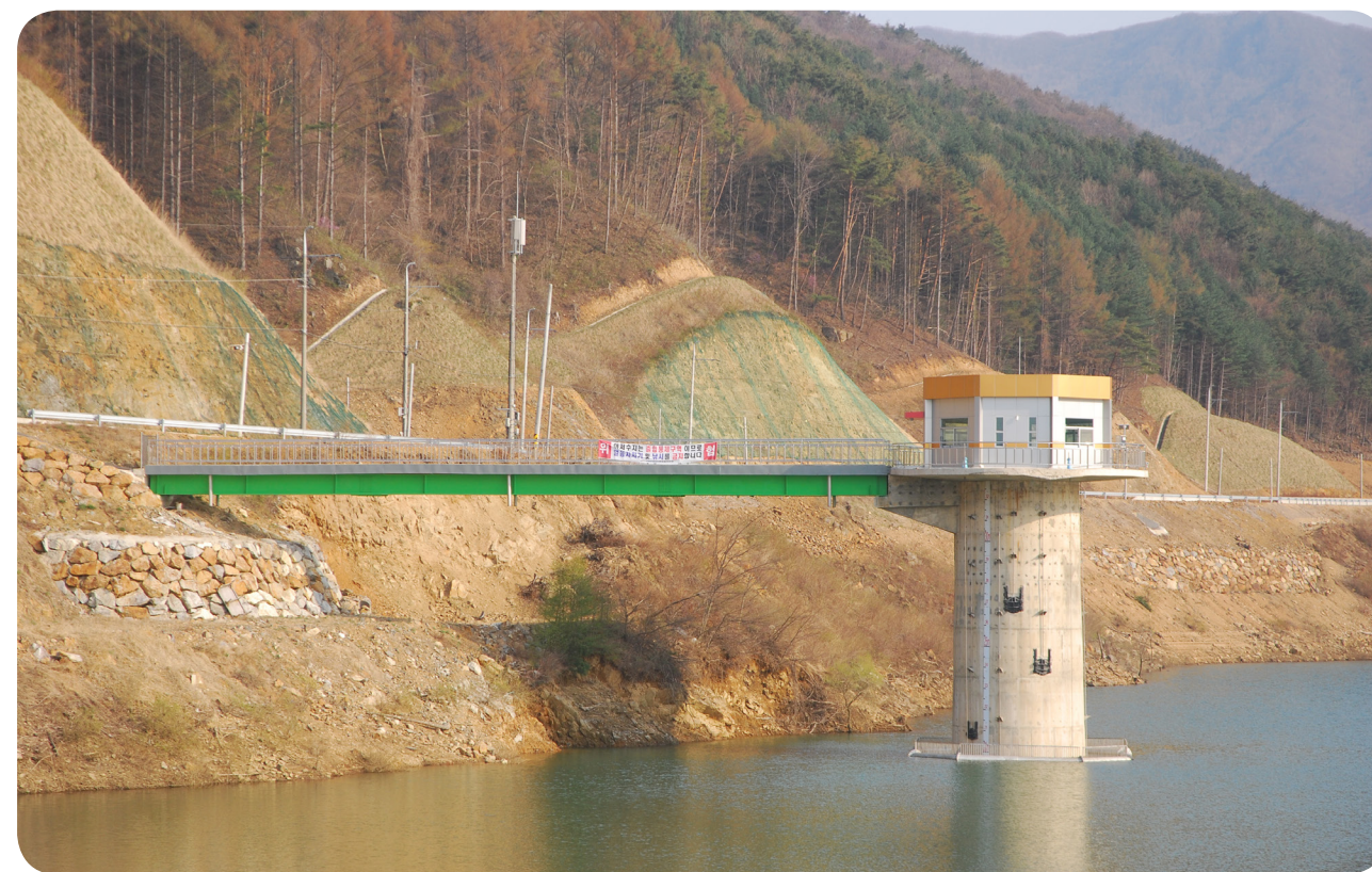
• 취수탑교 / L=34\text{m} , B=2.8\text{m} , H=1.09\text{m}
