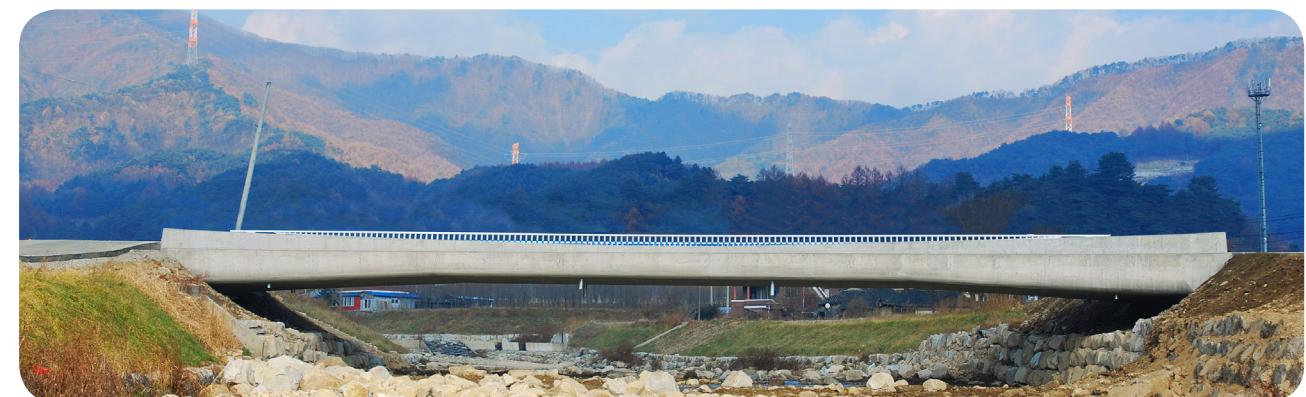
• 천촌교 / L=40m , B=5.9m , H=1m , Skew=95^\circ
