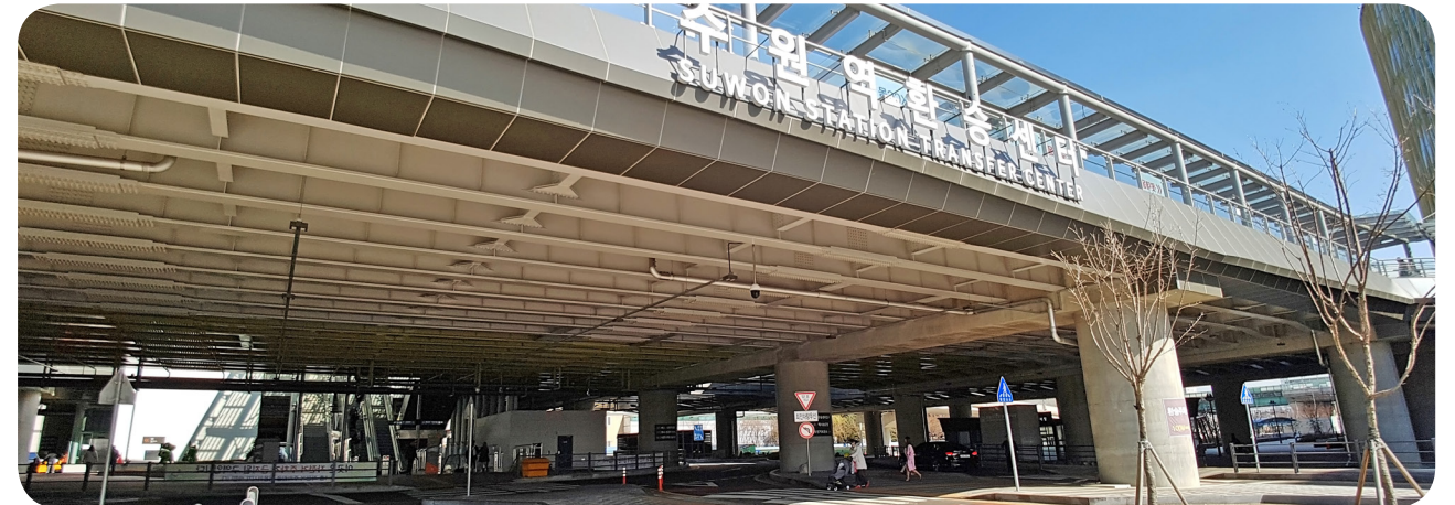
● 수원역 환승센터 / L=17m+26.4m+34m+23m+23m+15.4m=139m, B=94m, H=0.8~1.1m
