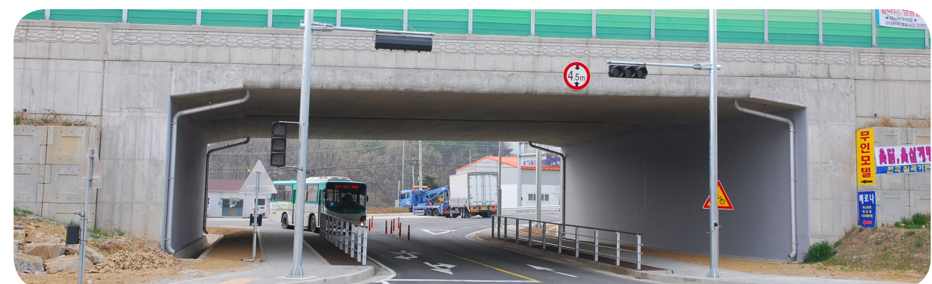
• 철곡4교 / L=20m , B=24m , H=0.7m , Skew=90^\circ
