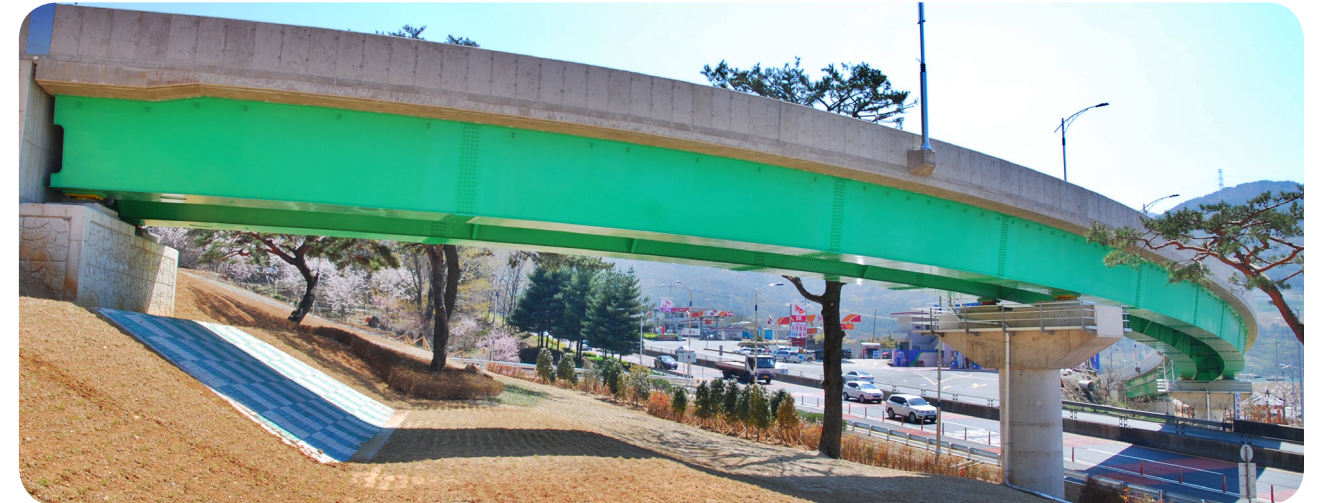
• 창원고가교 / L=45m+60m+35m=140m , B=7m , H=2.2m , R=180
